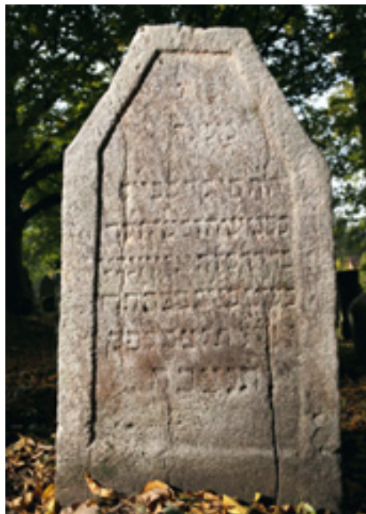
Abb. 4: Grabmal aus Blasen sandstein für den 1832 gestorbenen Veis ben Mosche. Der stark gefährdete Stein (drei parallele Vertikalrisse) wurde 2019 durch Fa. Bauer-Bornemann Steinkonservierung gesichert und konserviert (Rissverschluss, Vernadung). Foto: Felix Groß
