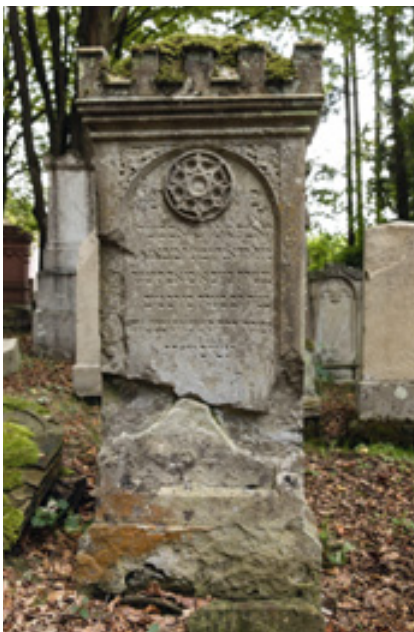
Abb. 11: Dieses Grabzeichen aus feinkörnigem Sandstein weist Sockelschäden durch aufsteigende Feuchte im Quellbereich sowie Vandalismusschäden (Abschlagen) auf. Foto: Günter Schmidt
