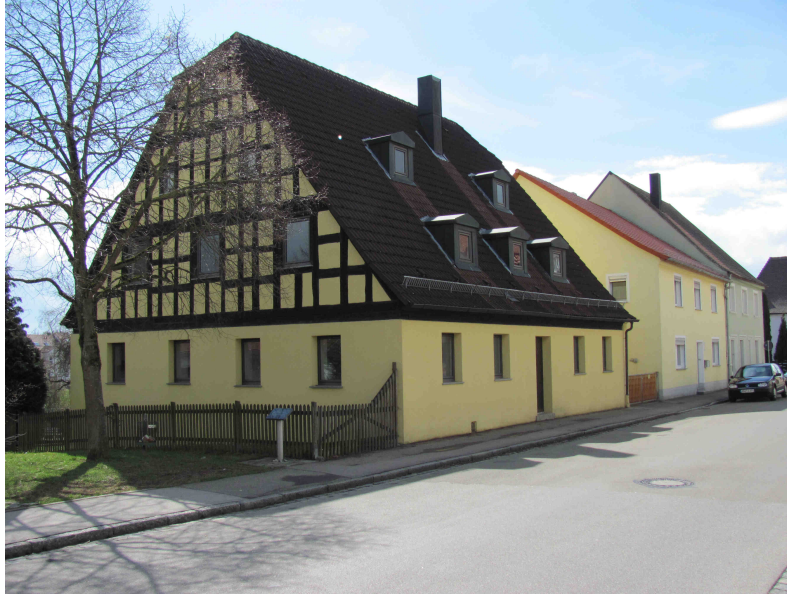
Die ehemalige Judenschule in der Bahnhofstraße 8
